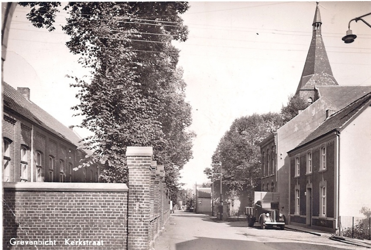
Links de oude school met ommuurde speelplaats.
